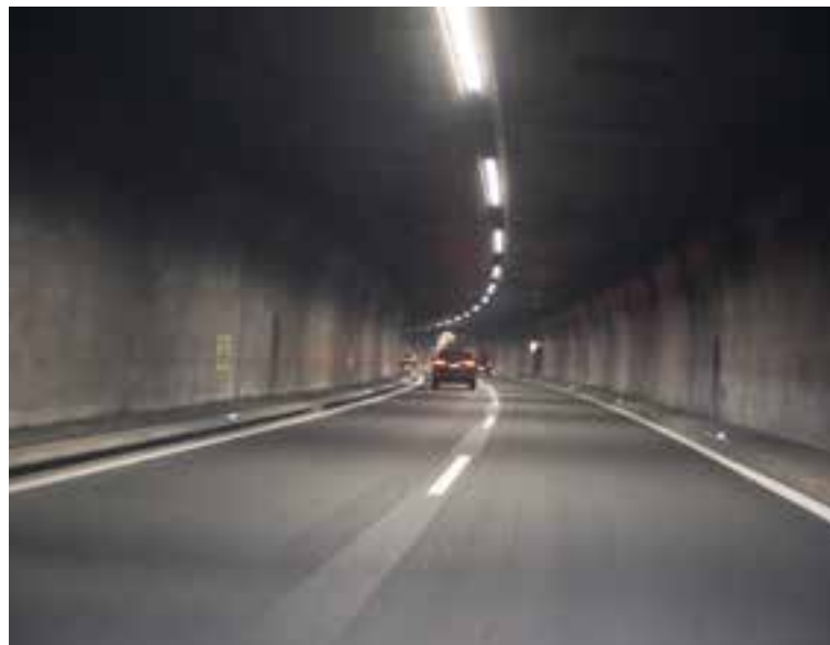
Des règles spécifiques s'appliquent dans les tunnels.
